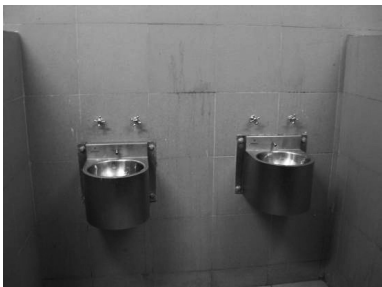
Instalación de nuevos sanitarios. Recambio de cerámicos
